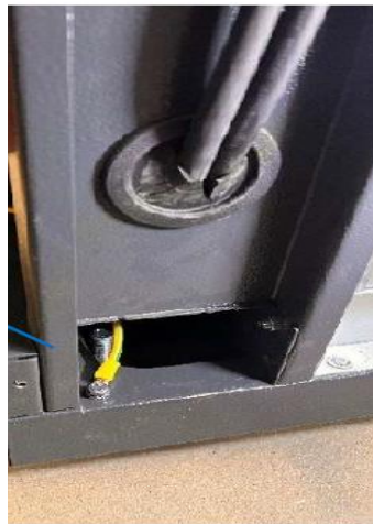
Abb. 9 - Erdung Gehäuse-Sockel
